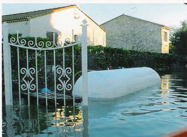
Cuve soulevée par l'eau.
